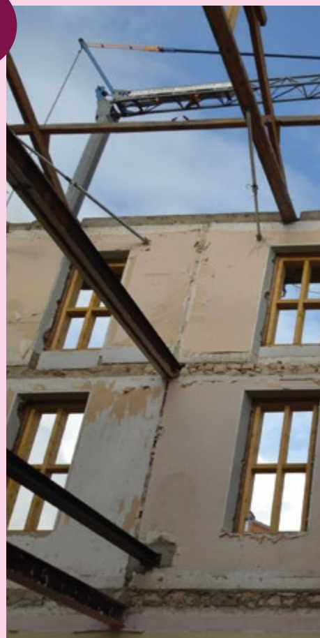
Arrivée des premiers modulaires de l'école provisoire
